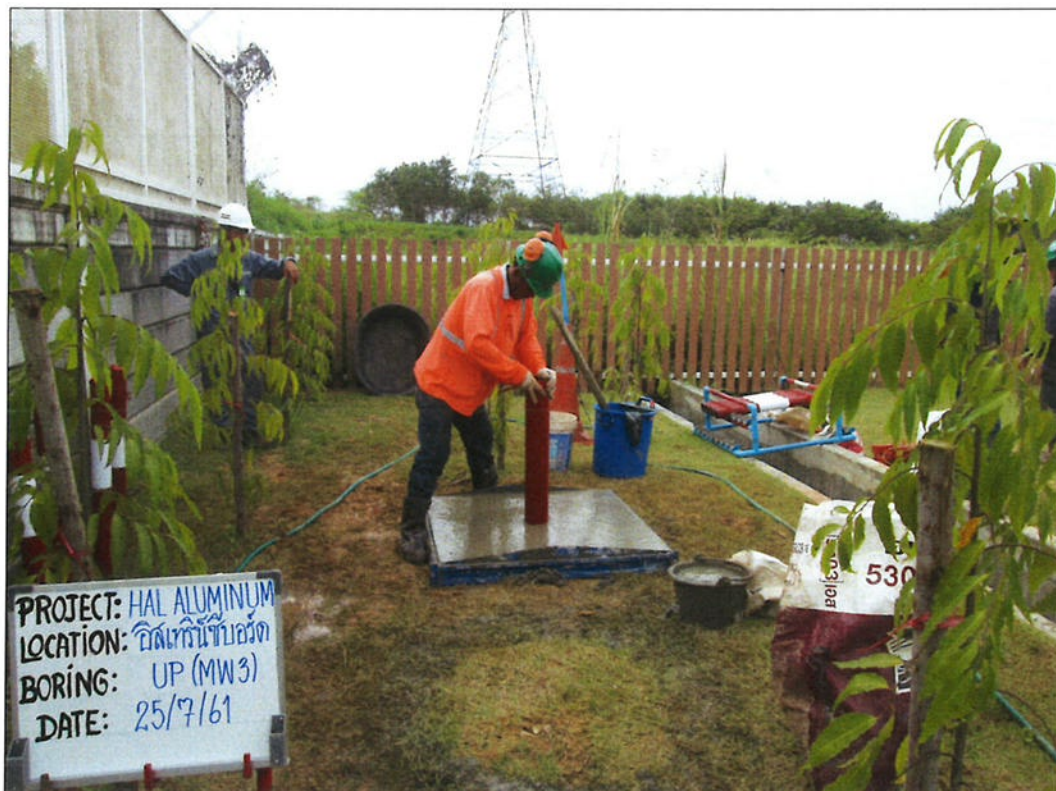
งานติดตั้งท่อเหล็กครอบบ่อ
