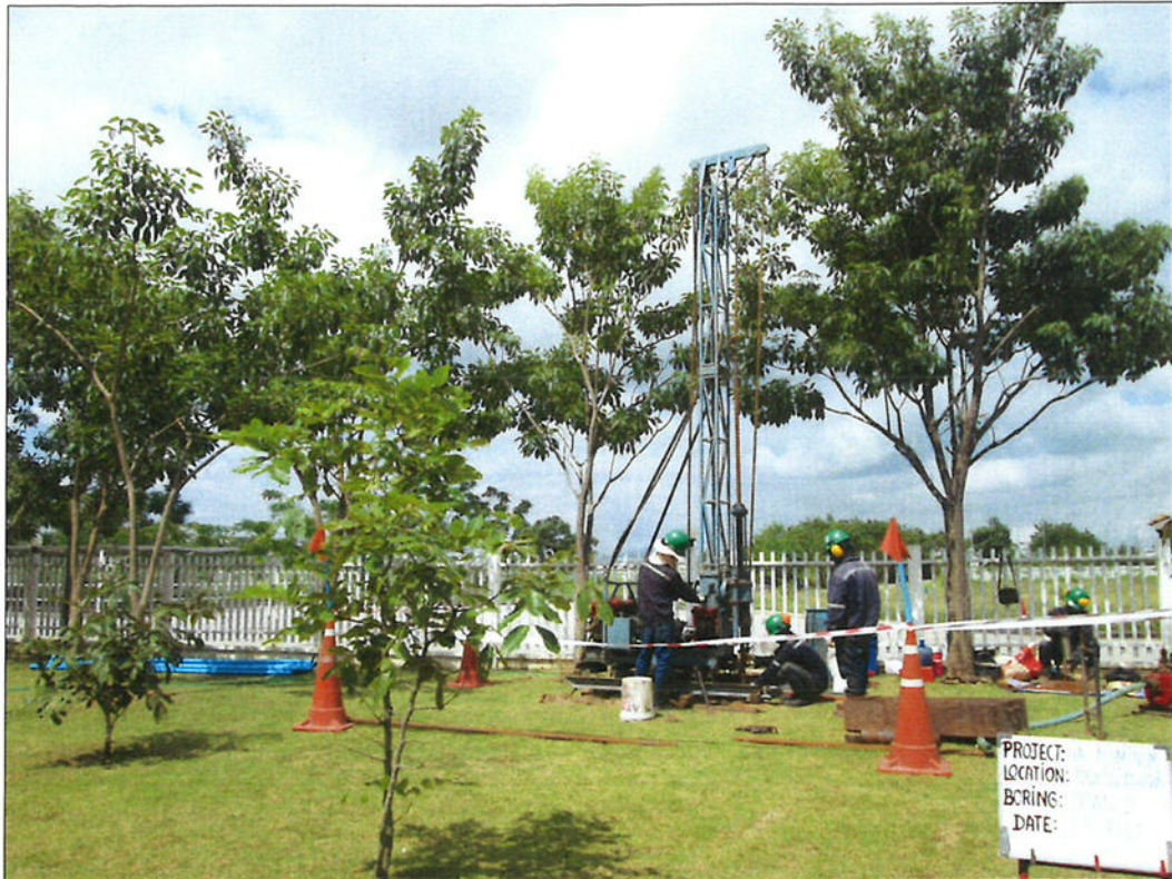
งานเจาะดินโดยเครื่องเจาะ
