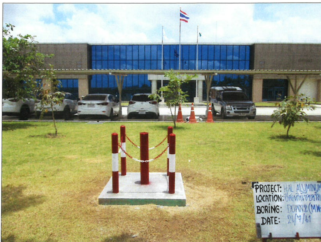
บ่อสังเกตการณ์ MW-2 ที่ทำการติดตั้งเสร็จเป็นที่เรียบร้อย
