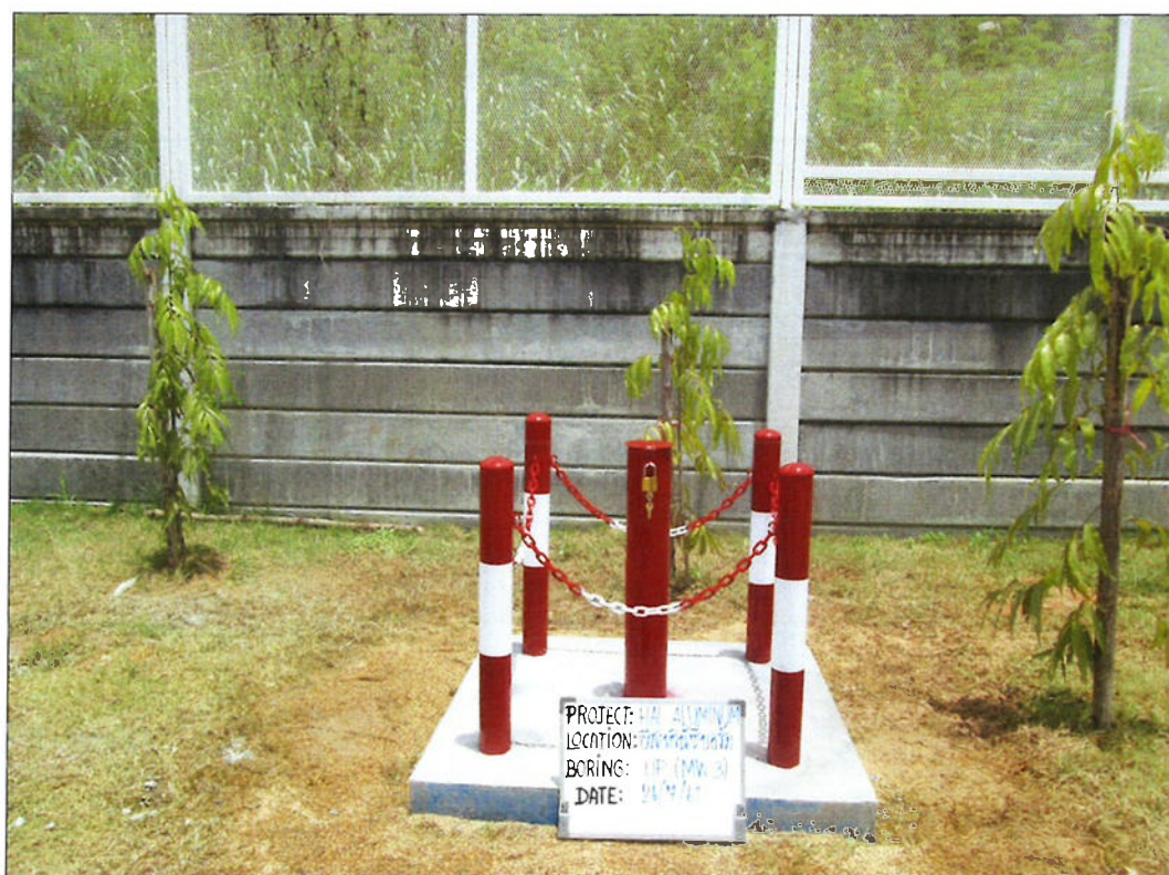
บ่อสังเกตการณ์ MW-3 ที่ทำการติดตั้งเสร็จเป็นที่เรียบร้อย
